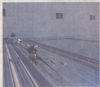
スカイ工法の施工現場。折板屋根にアルミ箔シートを両面テープで貼り付ける
